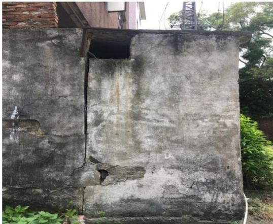
墙体出现裂缝由表面伸入构件内
